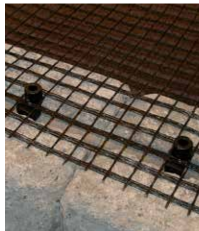
Bild 3. Montering av Bender Geonät på första skiftet. Sätt fast nätet över låspluggarna. Låt pluggarna sticka upp ur tredje raden på nätet så att så mycket nät som möjligt ligger mellan stenlagren utan att sticka ut. Då sitter nätet bäst.
