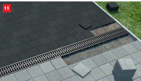
För stabilitet och fasthållning läggs beläggningssten i betong.
