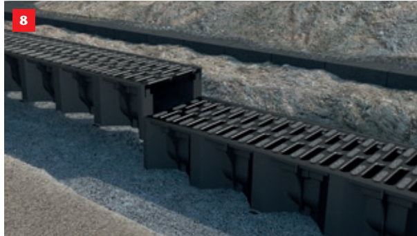
Kontrollera att rännan är placerad vågrätt eller med lätt lutning mot utloppet.
