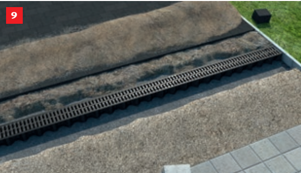
Vid en rännlängd på över 5 m kan delarna skjutas ihop vartefter. Börja med utloppsdelens.
